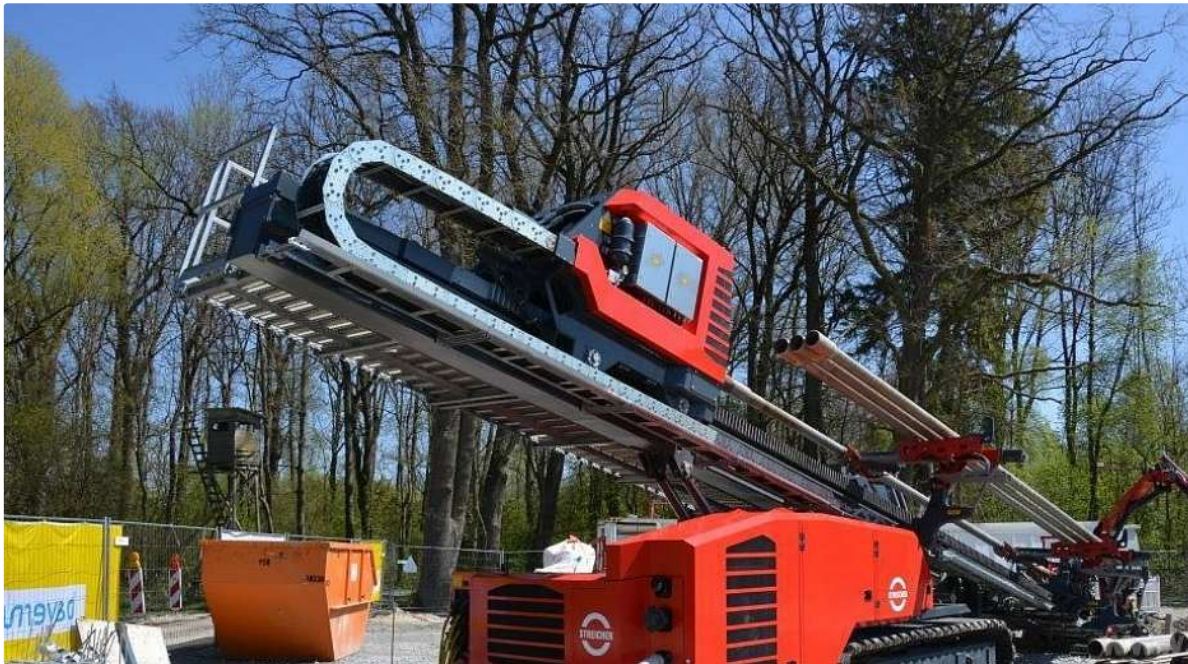
Die Bohranlage bahnt sich derzeit 20 Meter unter der Isar ihren Weg. In einer Woche schafft sie so eine Distanz von etwa 500
